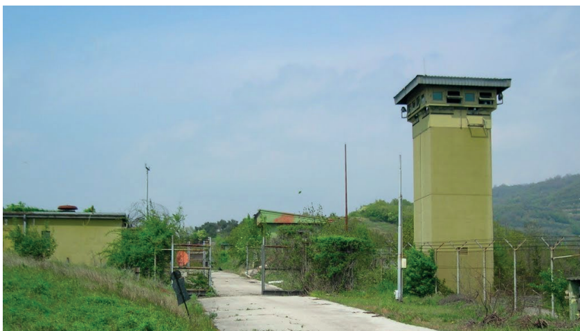
■ Foto del sito Calvarina: la torre interna
