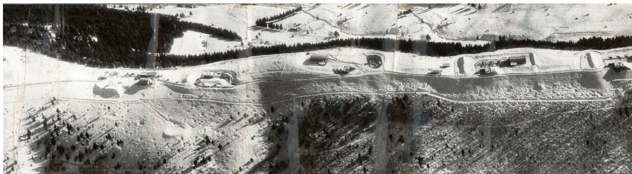
■ Una veduta aerea della base missilistica operativa sul monte Grappa
